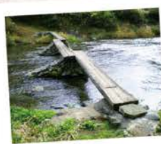
沈下橋の原形 #早瀬の一本橋 #津野町芳生野
